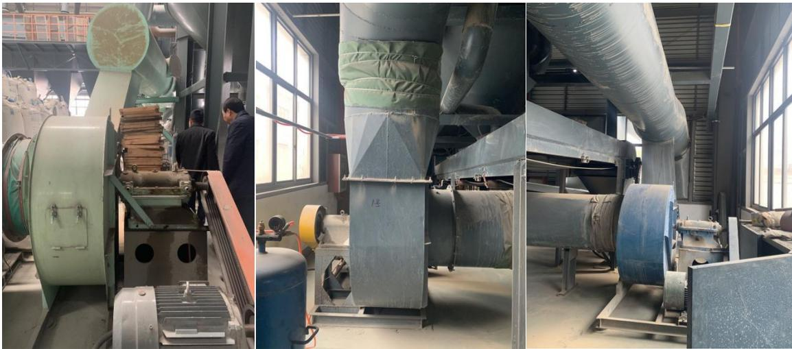
图 4.1-2 废气收集+除尘设施图
