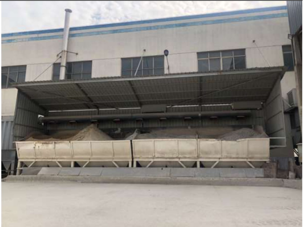
投料粉尘经集气罩收集+布袋除尘处理废气装置
