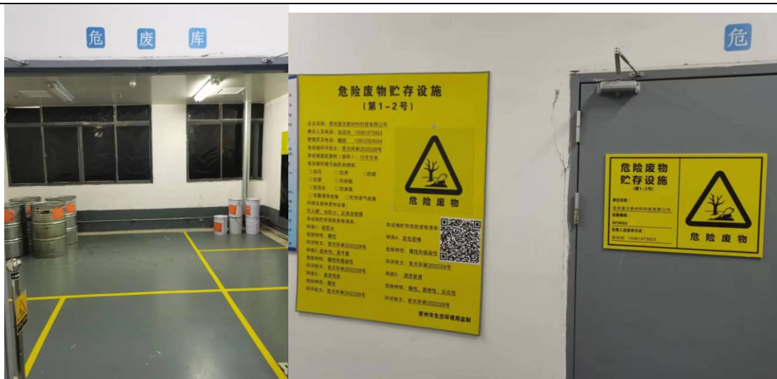
危废堆场内部
